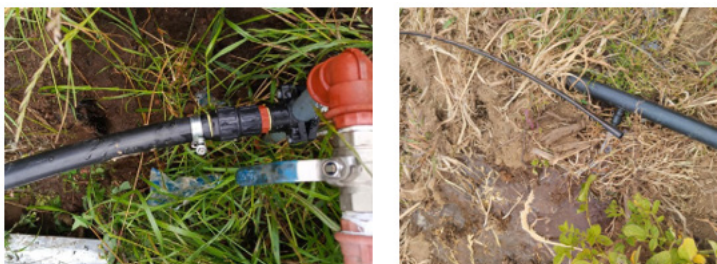
Figura 11. Revisión de fugas en goteros y uniones.
