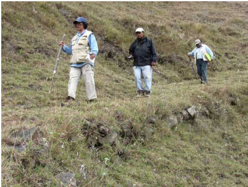
Figura 1.5. Tipología de camino. Plataforma corte talud con muro de sostenimiento. Fuente: Guama 3 (2010).
