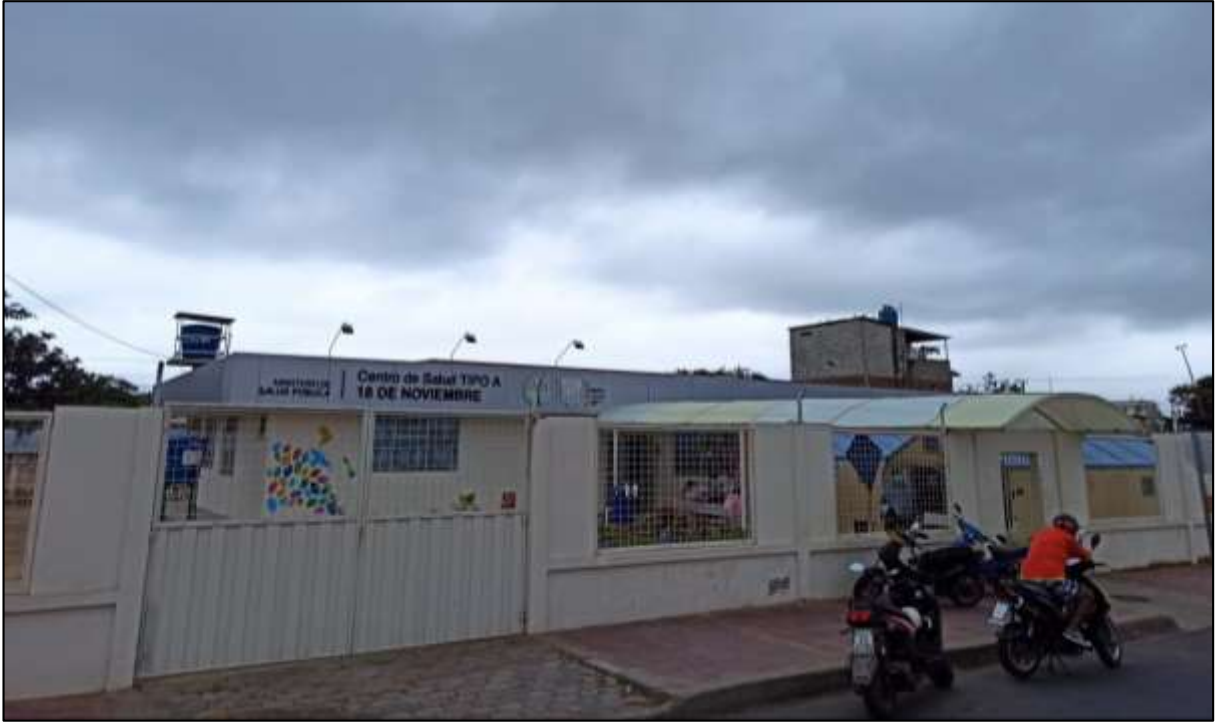
Fig 4. Centro de salud 18 de noviembre
